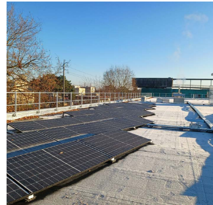
Toit terrasse de la Maison des Suds, installation de panneaux photovoltaïques.
