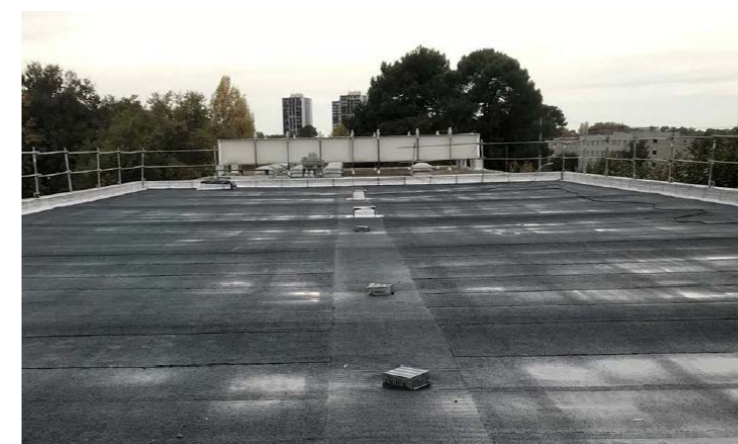
Toit terrasse de la Maison des Suds, isolation thermique.
