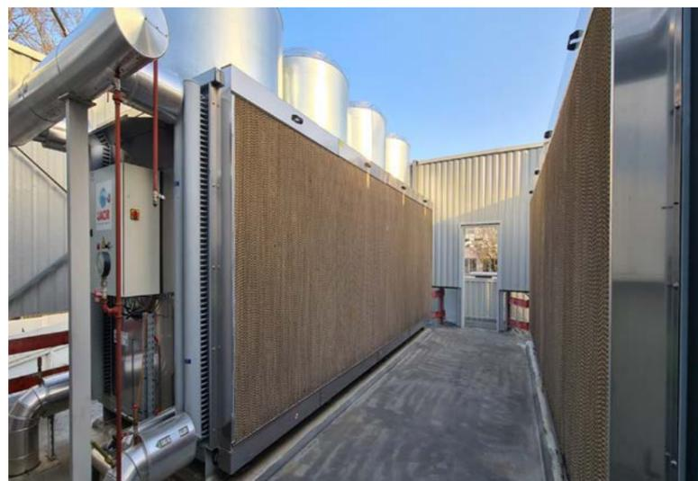
Le CNRS tente de trouver des solutions durables pour la rénovation et l'entretien de ses bâtiments et équipements de recherche. Ici, le système de refroidissement du supercalculateur Jean Zay, dont la chaleur sera récupérée et alimentera le réseau d'échange de chaleur et de froid du campus urbain Paris-Saclay. © Rafael MEDEIROS / IDRIS / CNRS Photothèque
